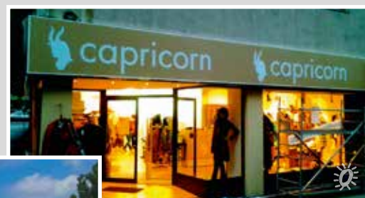
+ Portalverkleidung auf Unterkonstruktion mit Multiprofil und Klemmleisten 8 x 0,9 m
