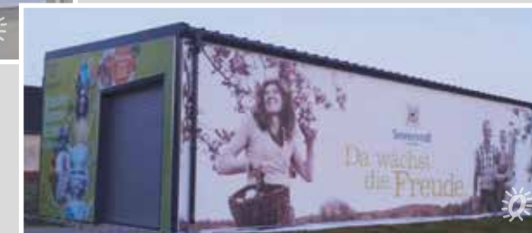
+ Hallenverspannung auf Trapezblech mit Multiprofil und Klemmleisten Höhe: 4 m, Torausschnitt bündig realisiert
